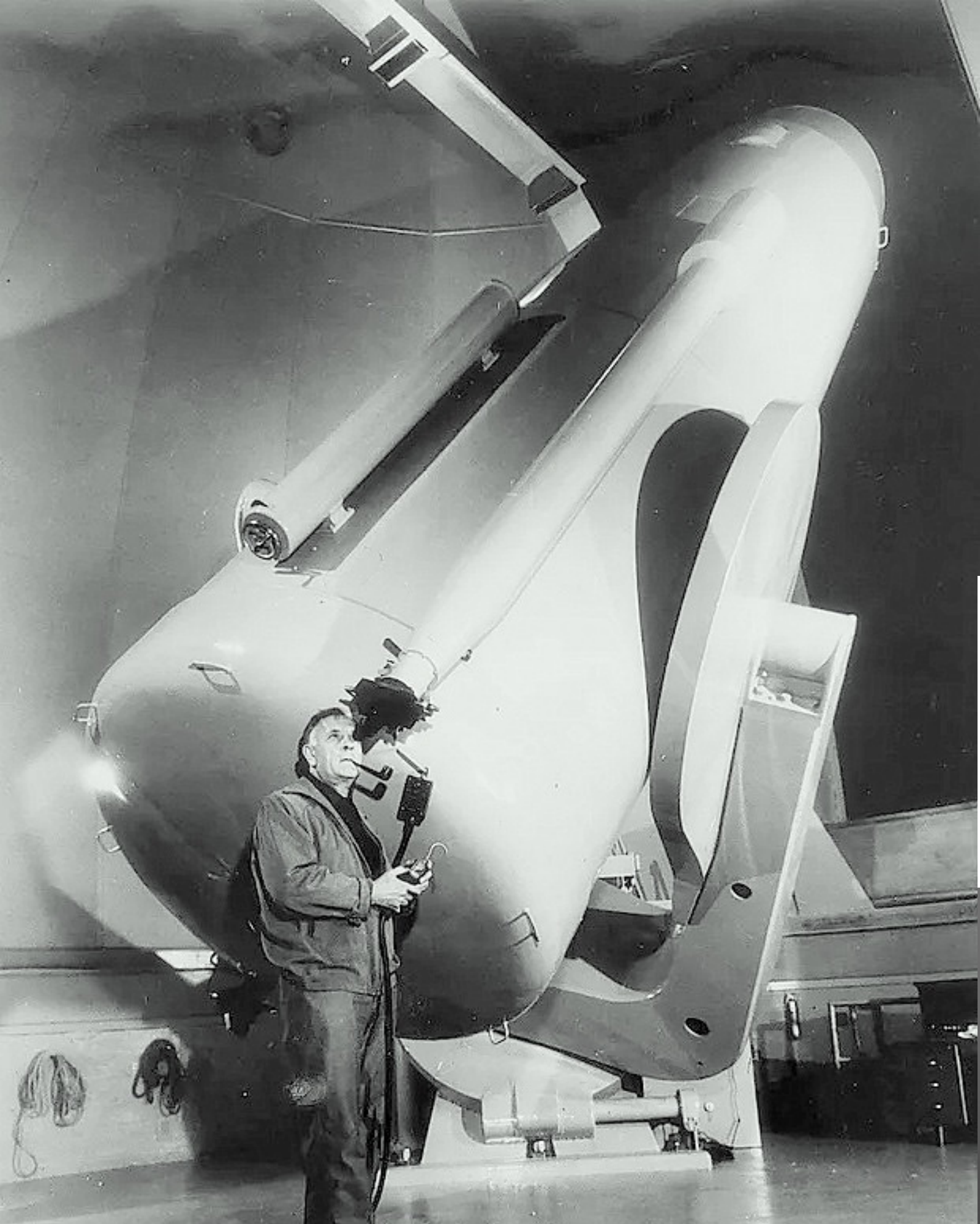
شکل ۴: تلسکوپ بازتابی (۱/۲۱ متری) رصدخانه پالومار کالیفرنیا آمریکا ساخت ۱۹۴۸ - ( در تصویر ادوین هابل در حال رصد می‌باشد).
